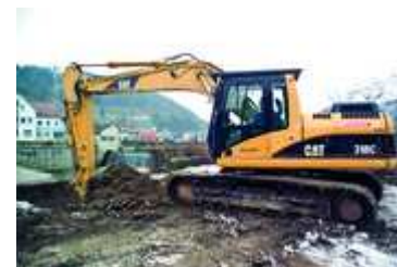
Aushub der Baugrube auf der Inselfspitze in Horb am Neckar
